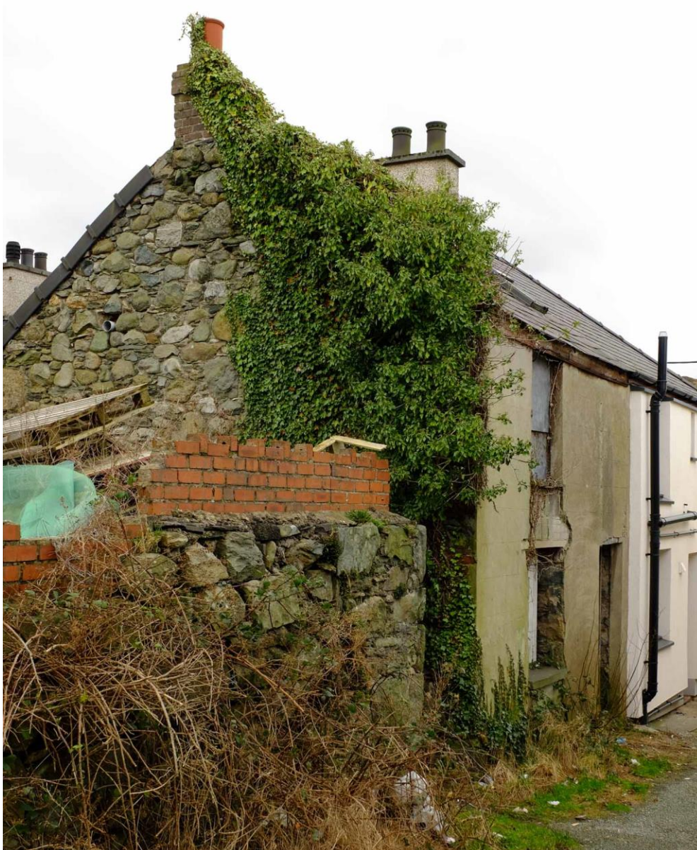
Ffigwr 19 Yn aml, ar yr ochr neu'r cefn y mae'r deunyddiau adeiladu o'r safon isaf, fel gwelir yma mewn tŷ y tu ôl i Green Terrace, a adeiladwyd o gerrig cae.
