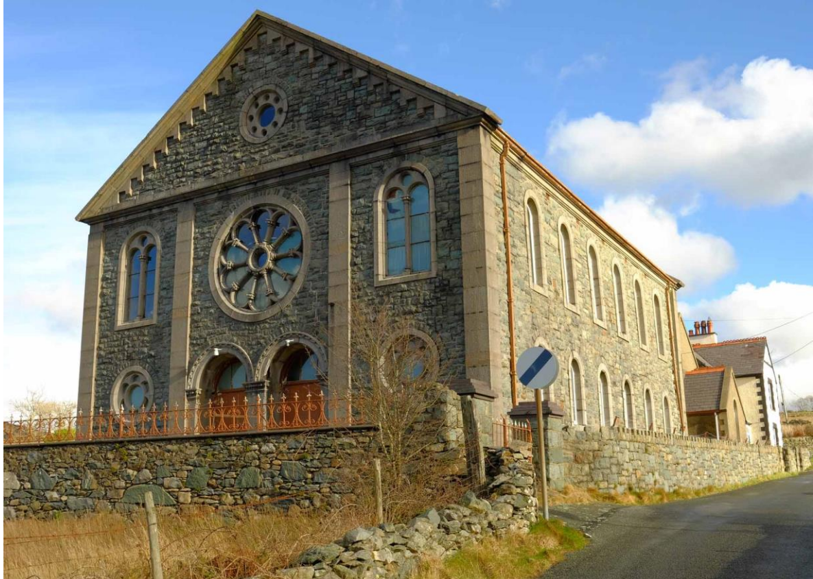
Ffigwr 14 Capel Cefn y Waun, 1868. Adeiladwyd ei flaen talcennog o gerrig gorchudd, llanw, gyda cherrig rhywiog wedi'u trin.
