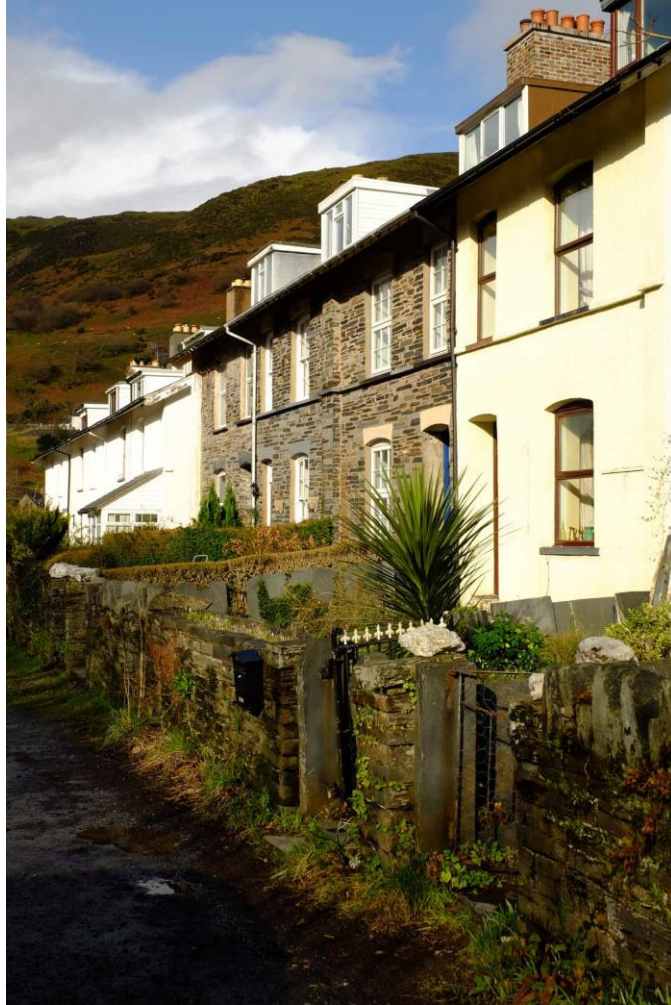
Ffigwr 16 Rhifau 13-24 Heol y Dŵr, yn dangos waliau gerddi blaen gyda phileri clwydi llechfaen a ffensys llechi (crawiau). Mae gan rifau 19-24 hefyd fand sil a sribedi pilaster.
