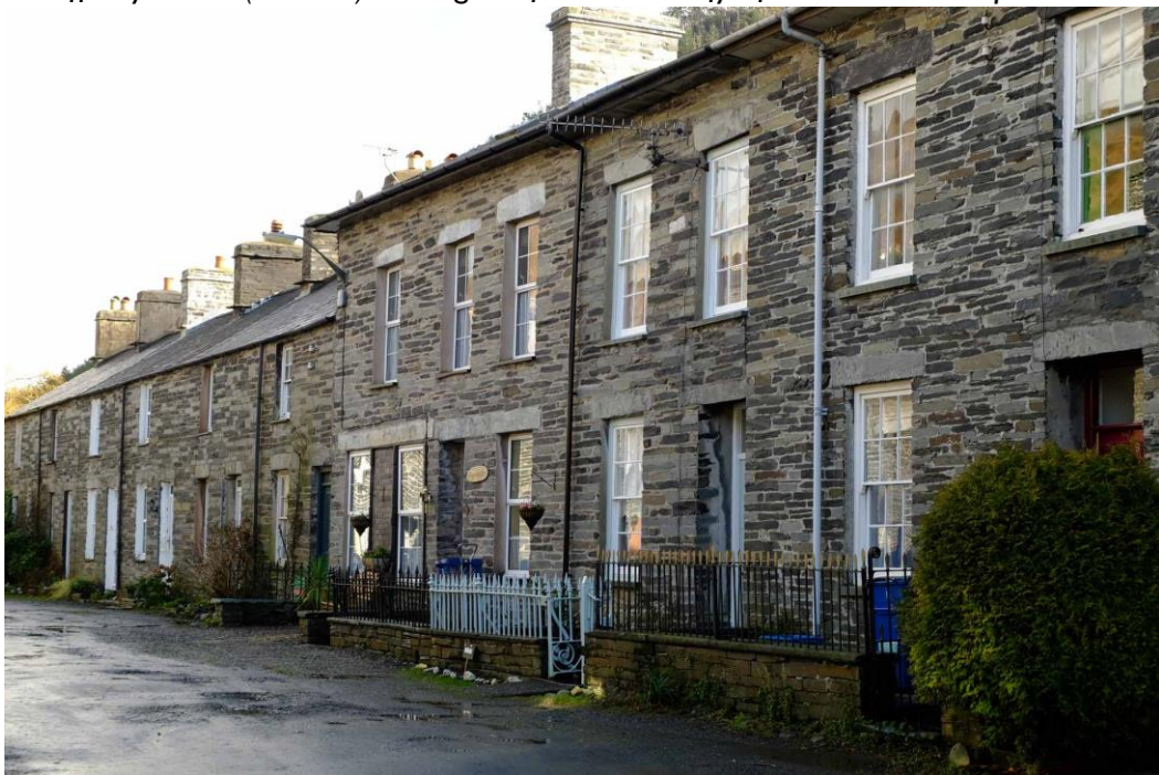
Ffigwr 16 Rhifau 13-24 Heol y Dŵr, yn dangos waliau gerddi blaen gyda phileri clwydi llechfaen a ffensys llechi (crawiau). Mae gan rifau 19-24 hefyd fand sil a sribedi pilaster.
