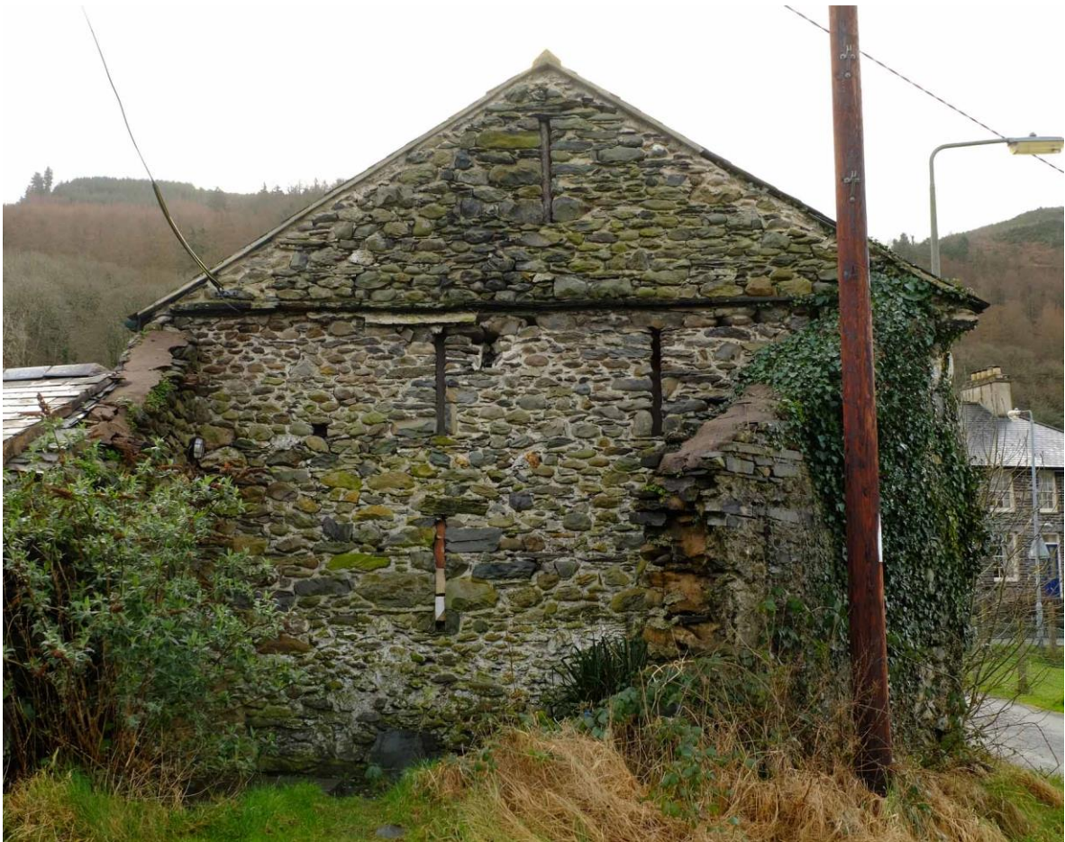
Ffigwr 10 Tŷ allan y tu ôl i'r Railway Inn yn dangos y sribedi awyru a'r adeiladwaith o feini maes.
