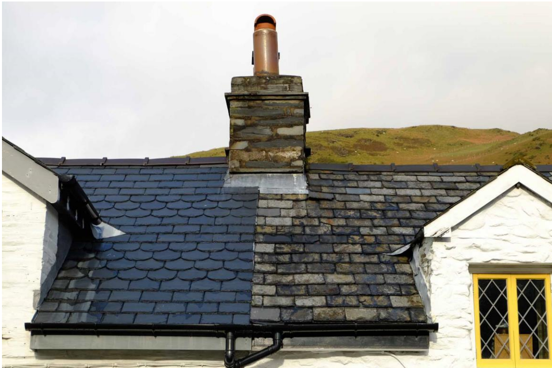
Ffigwr 24 Mae llechi to wedi eu hadnewyddu ar nifer o adeiladau, yn cynnwys y bythynnod hyn yng nghanol y pentref. Mae gan y to modern ar y chwith fandiâu o lechi cennau pysgod, sy'n absennol yn hanesyddol o'r pentref.
