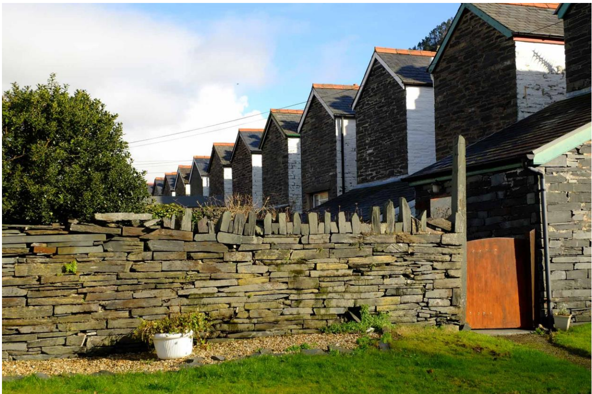
Ffigwr 22 Clytiau llechi tenau, mewn gwirionedd deunydd gwastraff o Chwarel Bryn Eglwys a ddefnyddiwyd i adeiladu waliau o'r 1860au.
